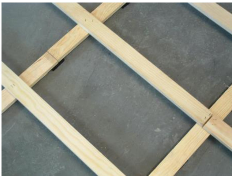
Fot.2. Montaż płyt względem listew rusztu.
